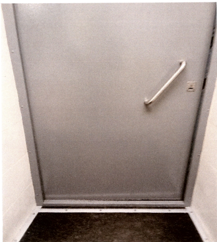
ФОТО №9 Дверь входная
