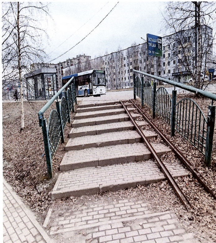
ФОТО № 50 Остановочный комплекс
