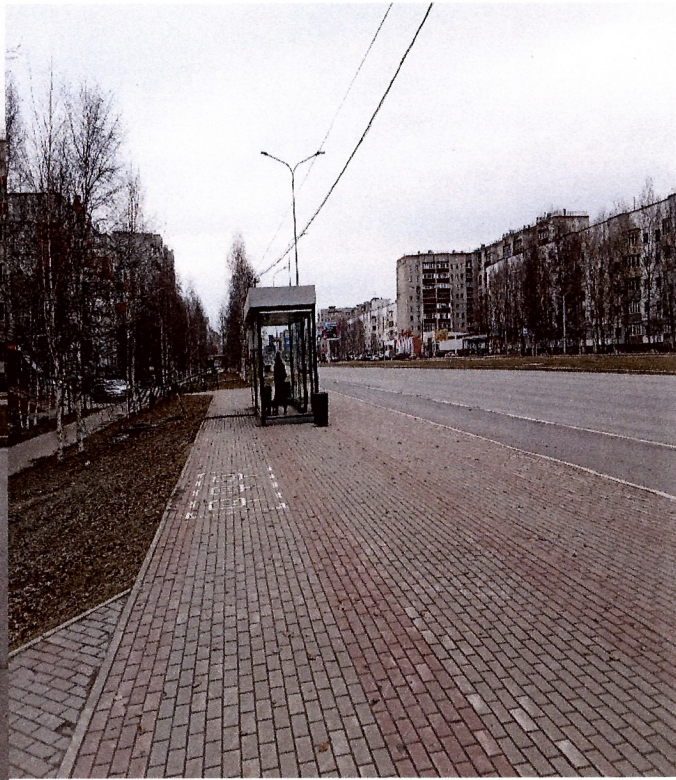
ФОТО №49 Остановочный комплекс
