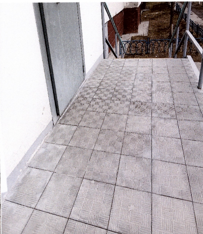
ФОТО №6 Входная площадка
