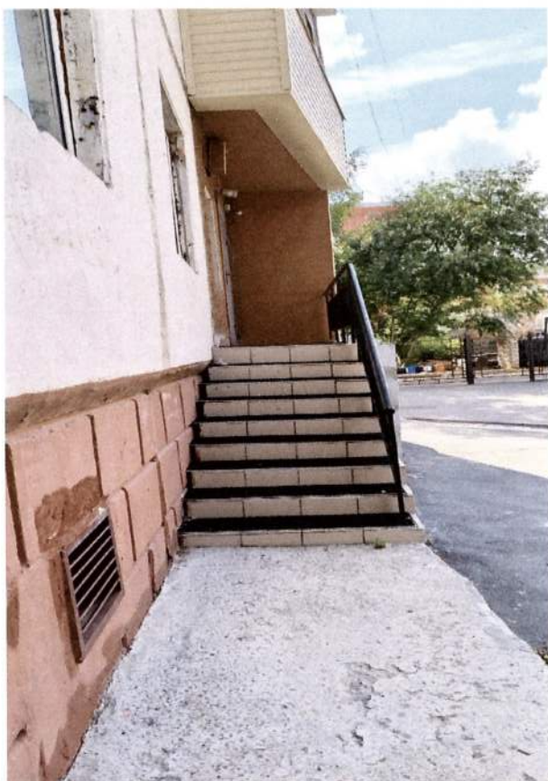
ФОТО № 36 Крыльцо запасного выхода (путь эвакуации)
