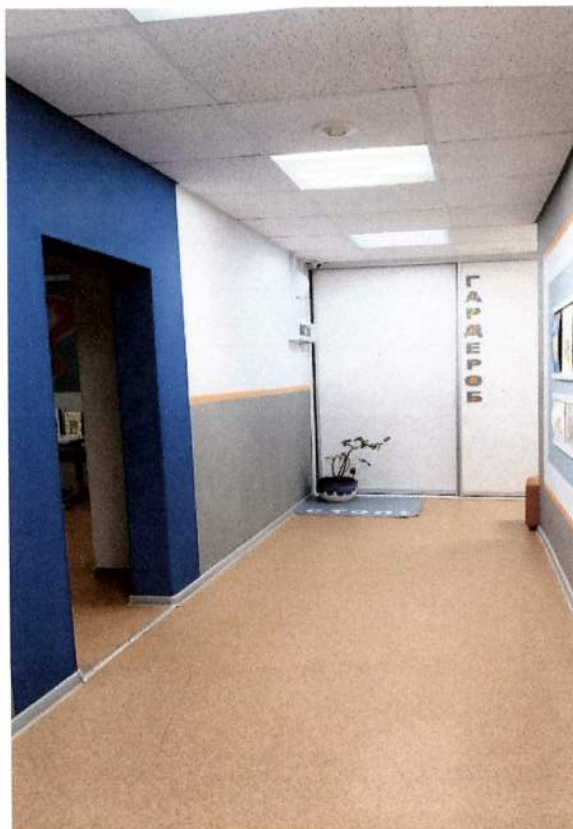
ФОТО № 29 Коридор (путь эвакуации)
