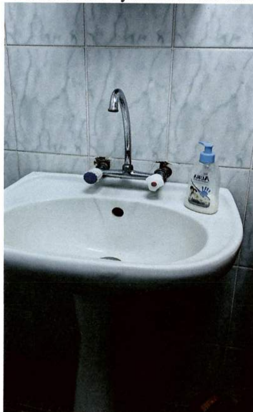
ФОТО № 61 Туалетная комната
