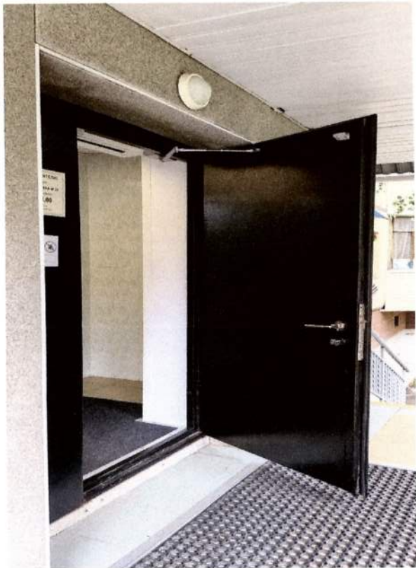
ФОТО № 20 Входная дверь
