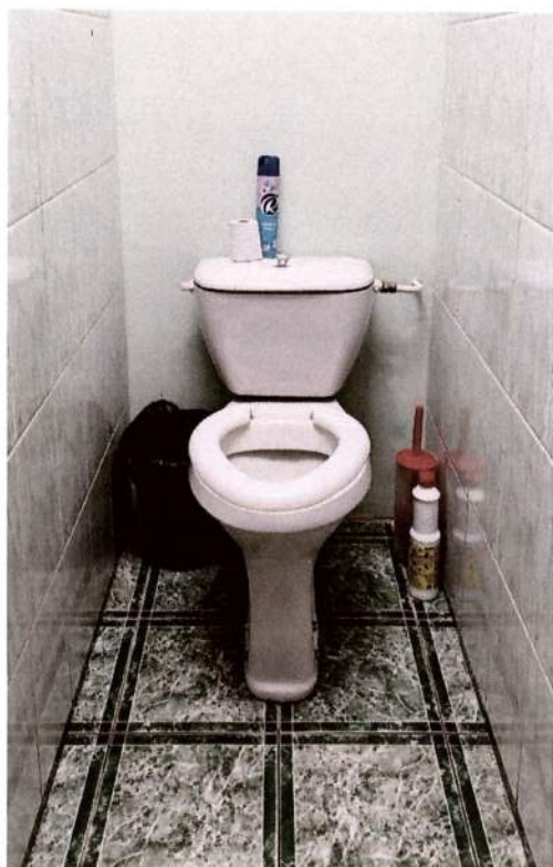
ФОТО № 60 Туалетная комната
