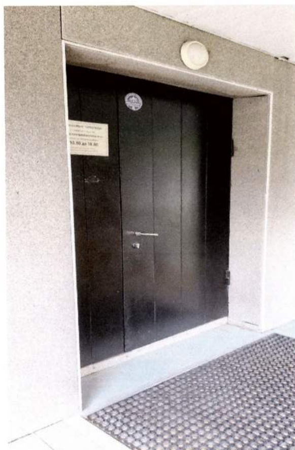
ФОТО № 19 Входная дверь
